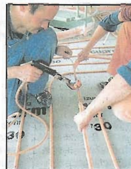
Окончательно трубы соединяют пайкой. После охлаждения места пайки опрессовывают контур.
