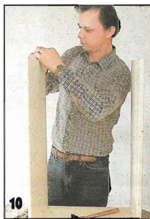
Аналогично устанавливают и вторую боковую стенку корпуса.
