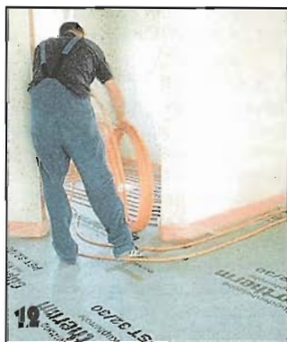
... завершают монтаж первого отопительного контура, соединив концы труб.
