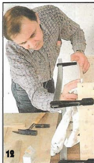
Собранный корпус временно стягивают струбцинами (по две с каждой стороны), подложив под губки струбцин деревянные прокладки.
