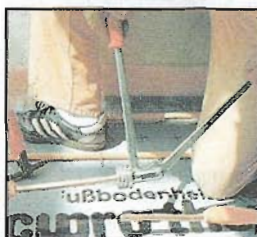
Чтобы соединить трубы одну с другой, конец одной из них раздают вширь.
