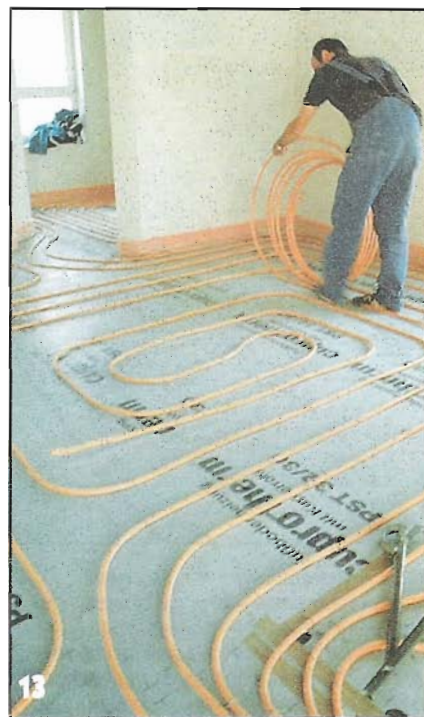
11 Подающая линия уложена, теперь нужно проложить от распределительного устройства обратную линию.
