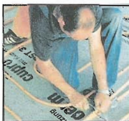
Торцы труб надо аккуратно обрезать, чтобы плотно состыковать одну с другой.
