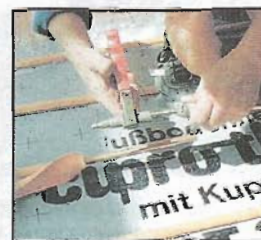
Торцы труб надо аккуратно обрезать, чтобы плотно состыковать одну с другой.
