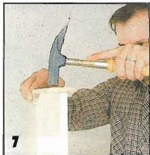
Положение боковой стенки подправляют легкими ударами молотка через деревянную подкладку.
