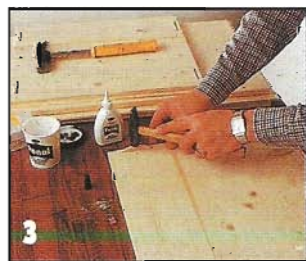
В пазы вставляют шпонки и аккуратно подбивают их молотком.
